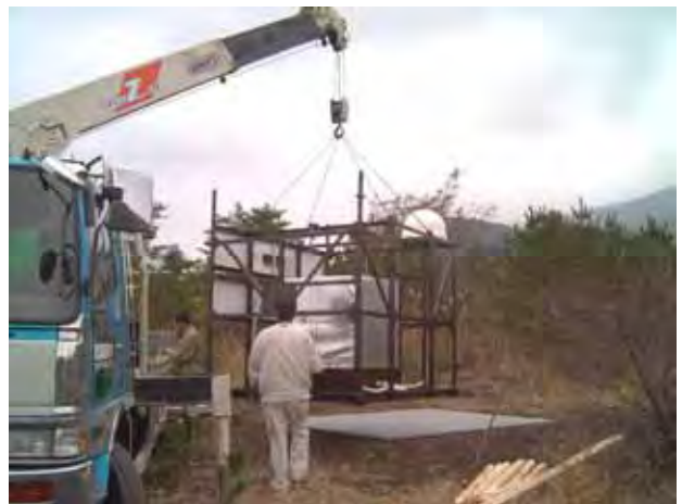
写真-3 M浅間砂塚の設置
