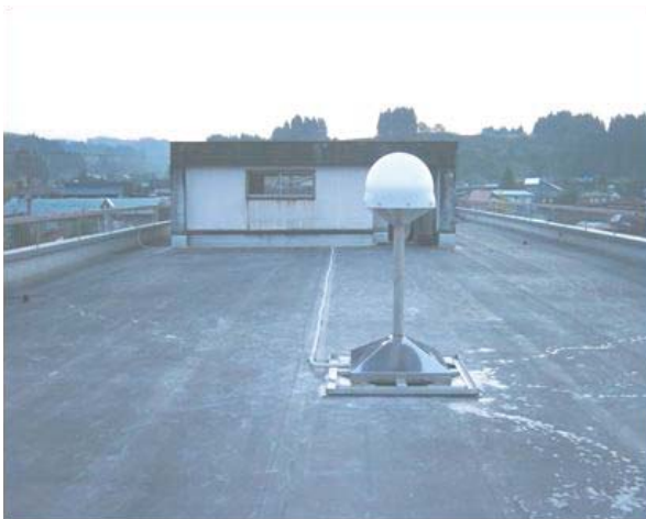
写真-2 堀之内小学校屋上に設置した GPS 機動連続観測点「M堀之内」
