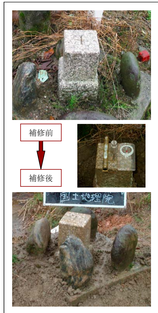
写真-8 僅かに傾斜していた三角点の補修状況
