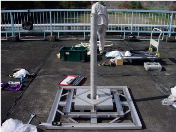
写真-1 アンテナ架台
