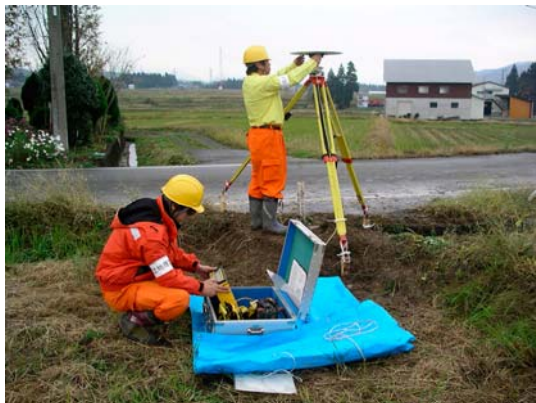
写真-9 GPS アンテナの設置(小千谷市)
