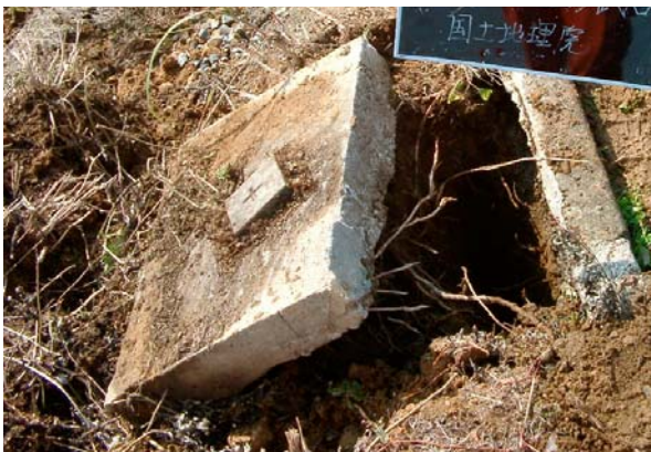
写真-6 崩れ落ちた三角点（小国町）
