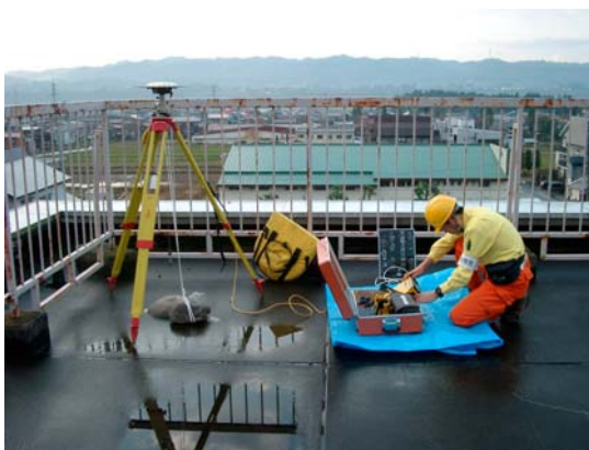
写真-10 屋上点の観測準備(魚沼市)
