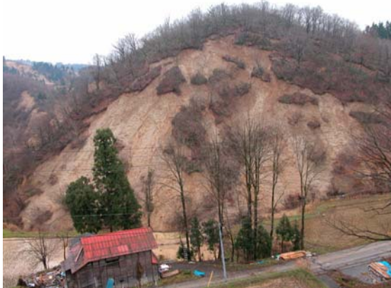
写真-2 崩壊B (旧山古志村池谷 平成16年11月30日撮影)
