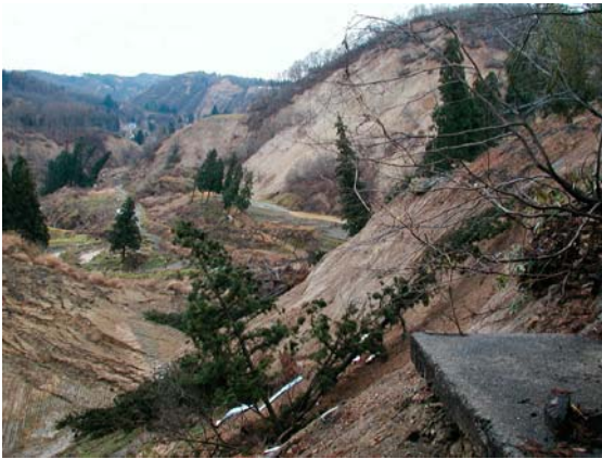
写真-5 地すべりB (旧山古志村池谷 平成16年11月30日撮影)
