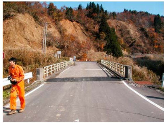
写真-3 崩壊C (旧山古志村種芋原 平成16年11月7日撮影)
