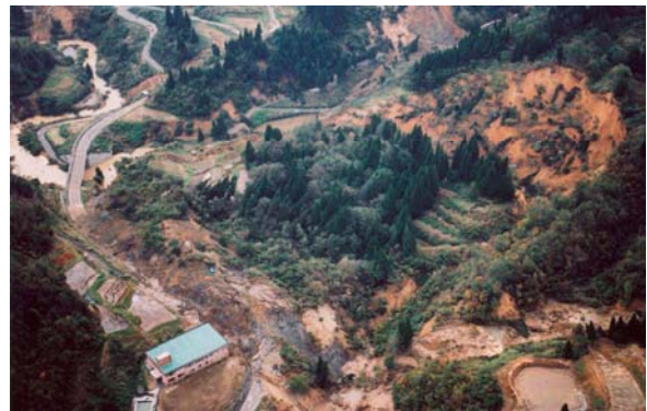
写真-4 地すべりA (旧山古志村東竹沢 平成16年10月中日本航空撮影)
