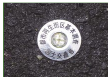
写真-3 街区補助点標識
