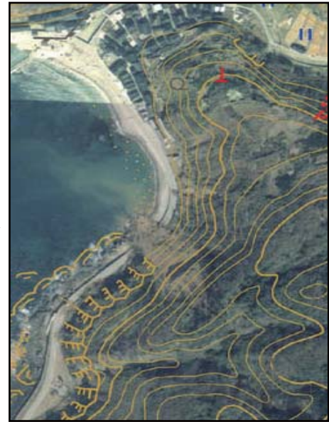
図-6 斜面崩壊（部分拡大図）
