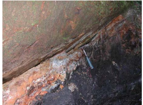
図-6 花こう岩類と泥岩のすべり面。左、南側（谷側）、右、北側（山側）。図の手前から向こうへ傾斜している。
