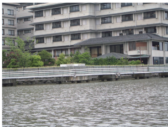
写真-12 パイプライン
