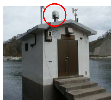
写真-2 「忍路」のGPS-P点（屋上型）
