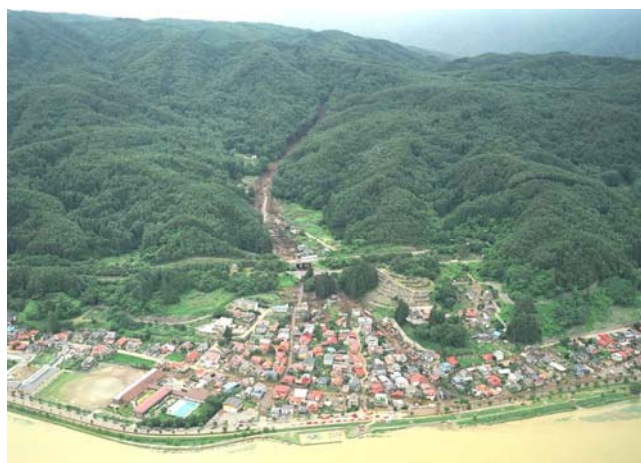
図-1 岡谷市湊地区小田井沢川の土石流の状況（7月20日、日本空間情報技術撮影による）
