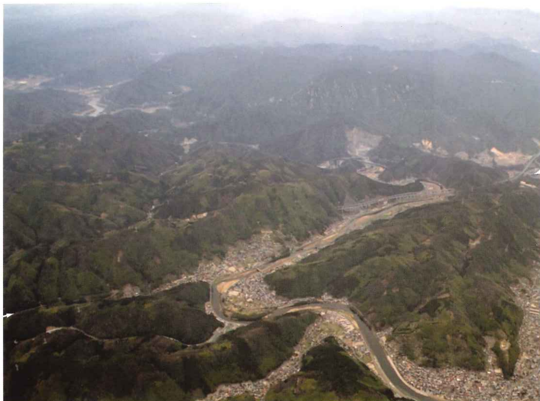
写真1 大竹上空から北西方向を臨む
