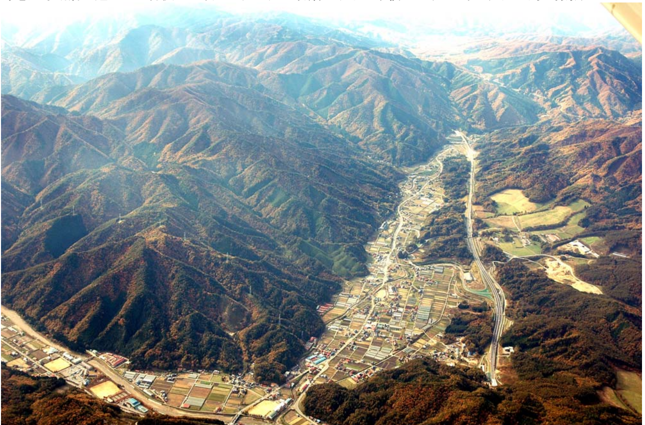
写真6 高山市清見町牧ヶ洞付近の牧ヶ洞断層と周辺の地形を西望 写真の右上下を高速道が通過。中央上部から右手にかけて、牧ヶ洞断層が通る。左手背後は飛騨高原の山地域(2007年10月岡田篤正撮影)。
