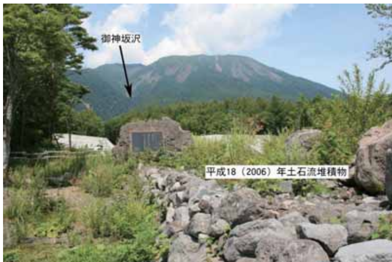
写真－9 御神坂沢の砂防堰堤と2006年土石流堆積物
