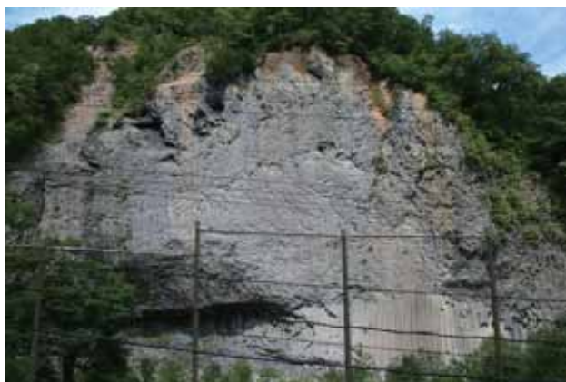
写真－10 崩壊後の葛根田の大岩屋(玄武洞)
