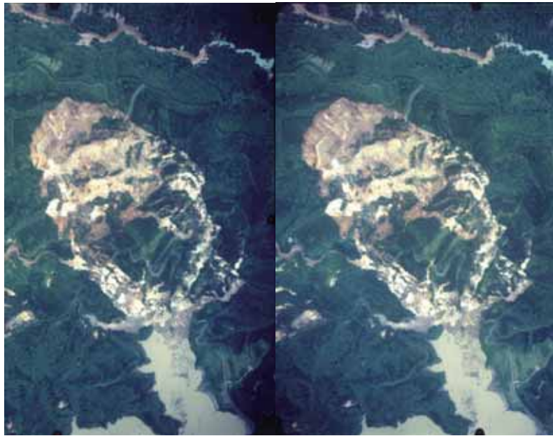
写真-35 二迫川上流荒砥沢ダム上流部斜面の地すべり 滑落崖の上部は溶結凝灰岩，下部は小野松沢層（立体視可能，国土地理院 2008 年 6 月 18 日撮影）
