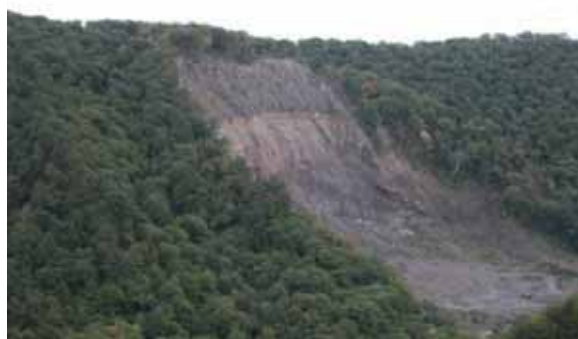
写真-34 地震による崩壊地 栗原市湯浜温泉付近, 上部の溶結 凝灰岩、下部は小野松沢層 (2010 年 10 月撮影)
