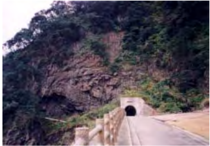
写真2 行者海岸トンネルの北側
