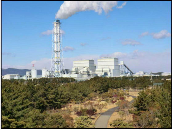
写真18 相馬中核工業団地東地区
