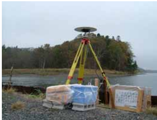
写真 - 4 ベンチマーク設置のためのGPS測量
