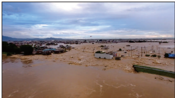
写真-5 UAVによる鬼怒川破堤箇所撮影
