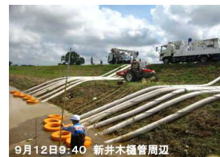
(常総水害時の排水ポンプ車の活動：関東地方整備局)
