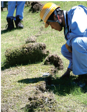
写真-5 地表変位確認作業
