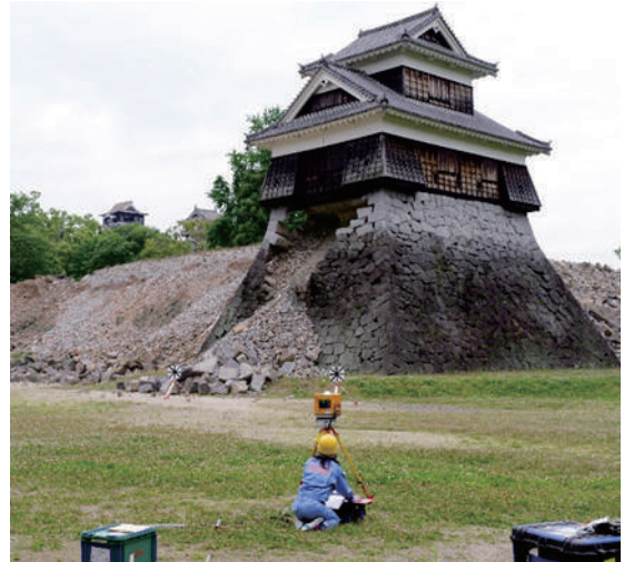
写真-6 地上レーザ計測
