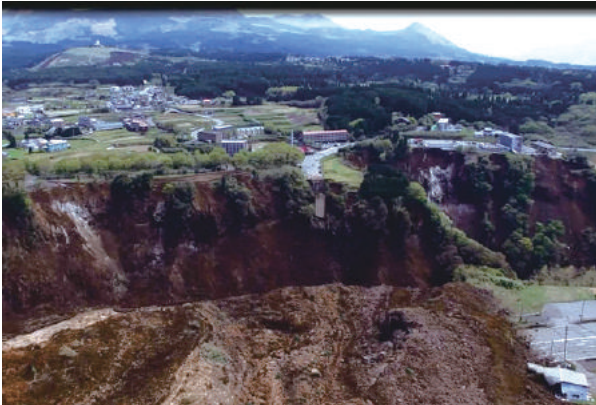
写真-2 阿蘇大橋周辺の土砂崩れ (4月16日撮影)
