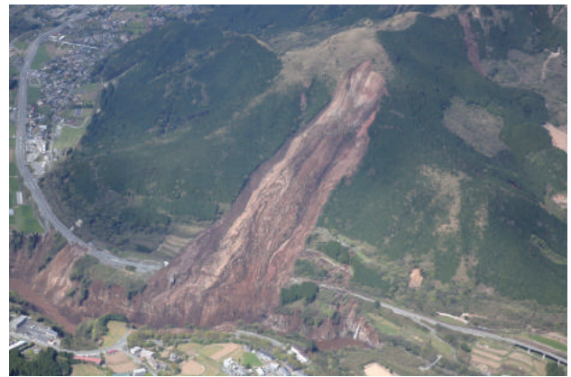
写真-1 南阿蘇村河陽地区の被害状況 (4月16日撮影斜め写真)
