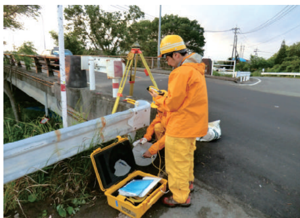
写真-3 益城町の要望に応え、水準測量の固定点の検証測量を行う国土地理院緊急測量調査班。
