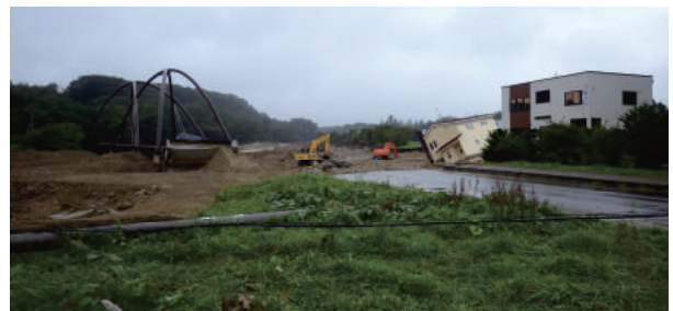
写真-3 清水町の河川氾濫による道路・建物被害と落橋被害の状況
