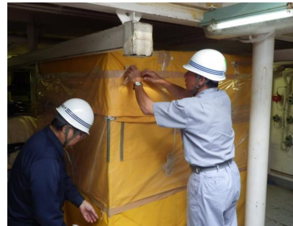
クリーンルーム設置
