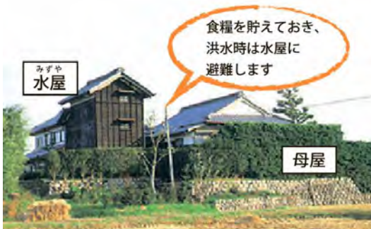
現在も残る水屋建築 (国土交通省木曾川上流河川事務所の写真を編集)
