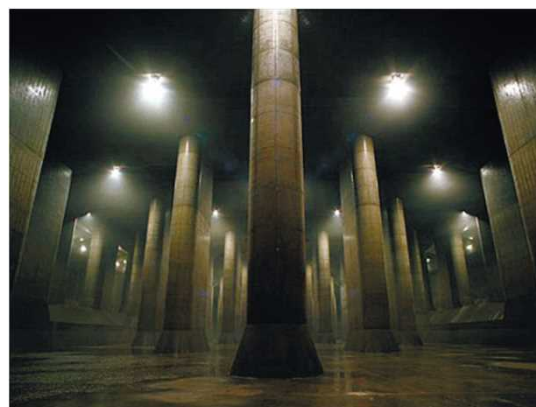
首都圏外郭放水路の調圧水槽 (国土交通省江戸川河川事務所より引用)
