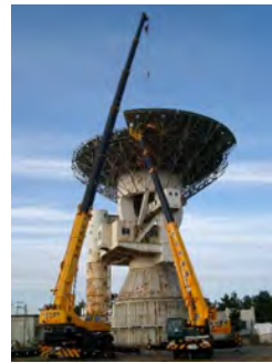
鹿島26mアンテナ解体作業
