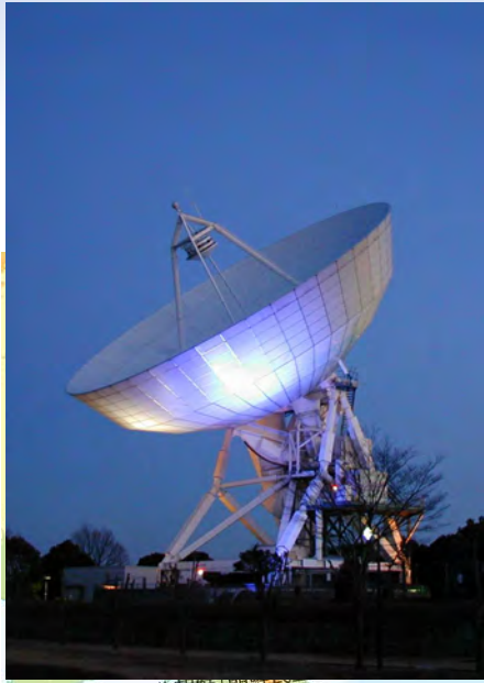
つくばVLBI観測局（茨城県） 完成：1998年3月 アンテナ直径：32m 駆動速度：3°/秒 2016年12月運用終了予定
