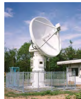
新十津川3.8mアンテナ
