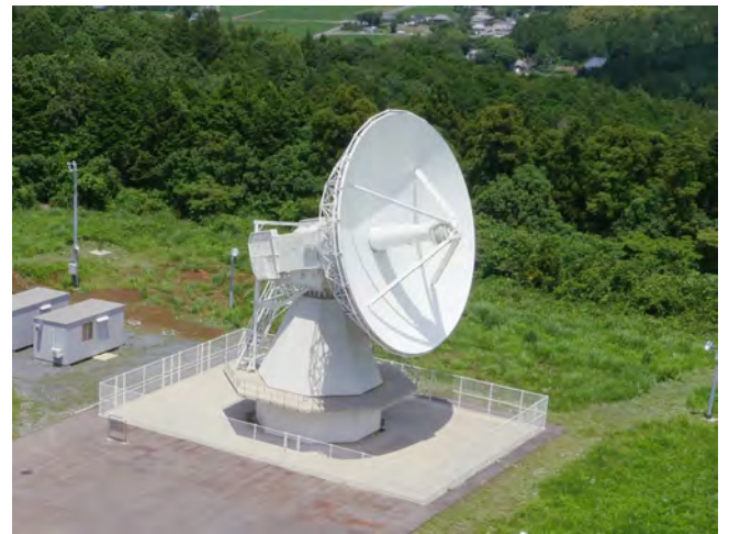
直径13.2mの石岡VLBIアンテナ
