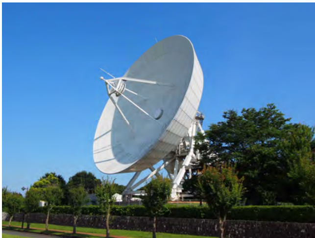
直径32mのつくばVLBIアンテナ
