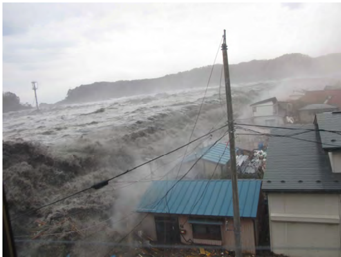
東日本大震災状況写真：岩手県宮古市 出典：岩手県建設業協会
