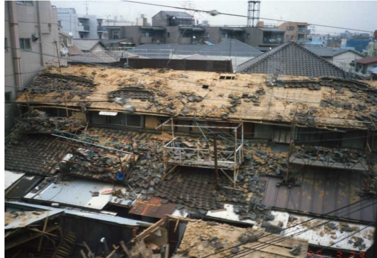
兵庫県南部地震 東灘区御影駅周辺の倒壊家屋 (写真提供：神戸市)
