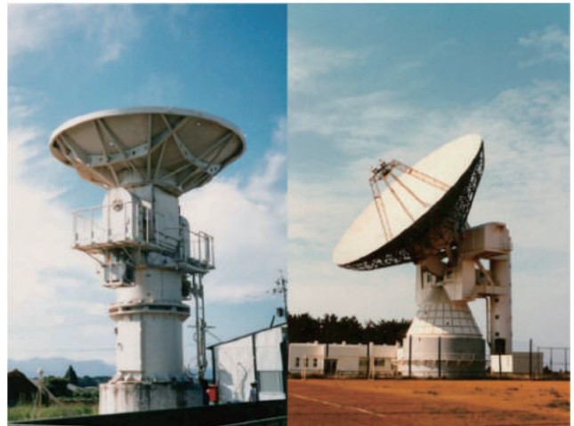
写真-1 (左) 5 m 可搬型アンテナ (宮崎県新富町)。 (右) 鹿島 26 m アンテナ (茨城県鹿嶋市)。
