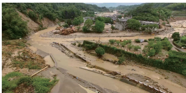
図-6 朝倉市赤谷川・乙石川合流部の UAV 動画の一部
