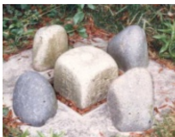
水準点（高さの基準） の再測量
