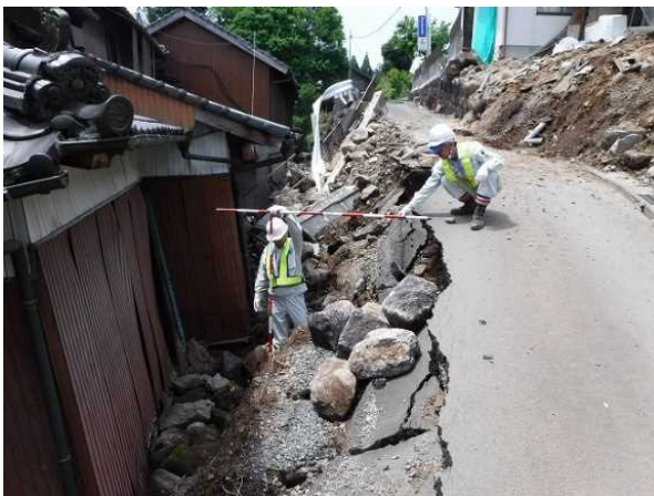
タイトル：地震、豪雨などの災害により被災した地域を迅速に復旧するための測量 氏名：大關 幸太 （住所：熊本県熊本市）
