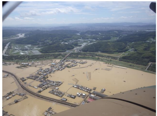
写真-1 被災箇所の上空視察 (岡山県倉敷市)
