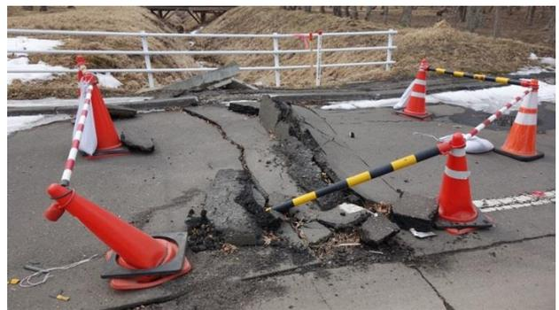
写真-1 図-4 中 A 地点の道路の変形
